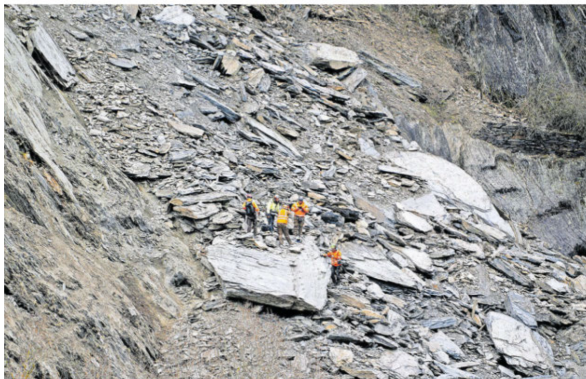
Arbeiter bereiten am Felsrutsch, der die vielbefahrene rechtsrheinische Bahnstrecke bei Kestert blockiert hat, Sprengungen zur Entfernung von weiterem gelockerten Gestein vor. Die Zahl von Felsstürzen und Steinschlägen nimmt allgemein zu.
