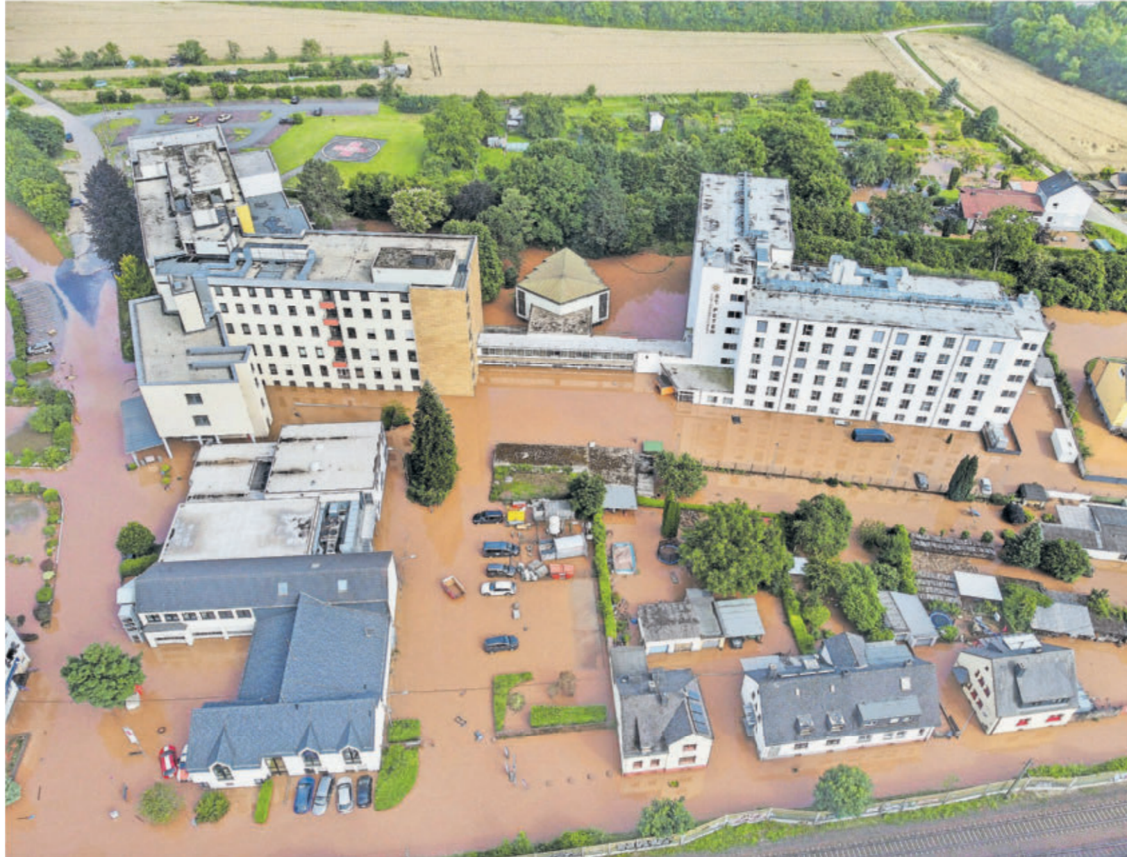
15. Juli 2021: Das Klinikum Mutterhaus Ehrang (links) und die Seniorenresidenz St. Peter stehen unter Wasser. Beide wurden evakuiert.
